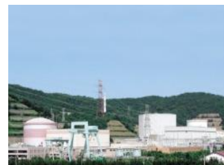
○デモンストレーション試験 (日本原電 敦賀原子力発電所)
