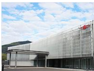
○モックアップ設備における動作試験 (日本原電 敦賀総合研修センター)
