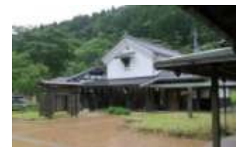
若狭熊川宿 資料展示館の改修整備
