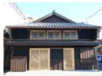
アレックス・カー氏監修の古民家ゲストハウス改修
