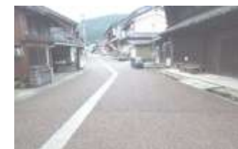
北国街道の道路空間整備
