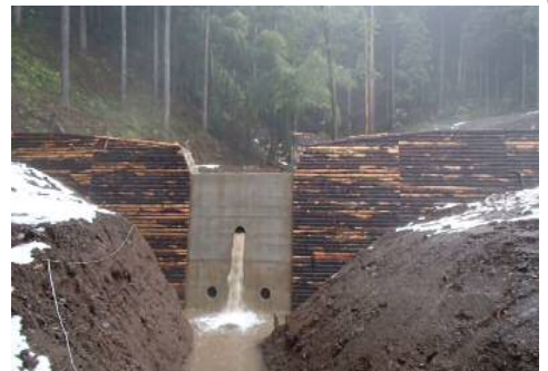
平成26年度完成ダム2
