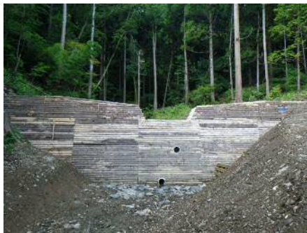
平成26年度完成ダム1
