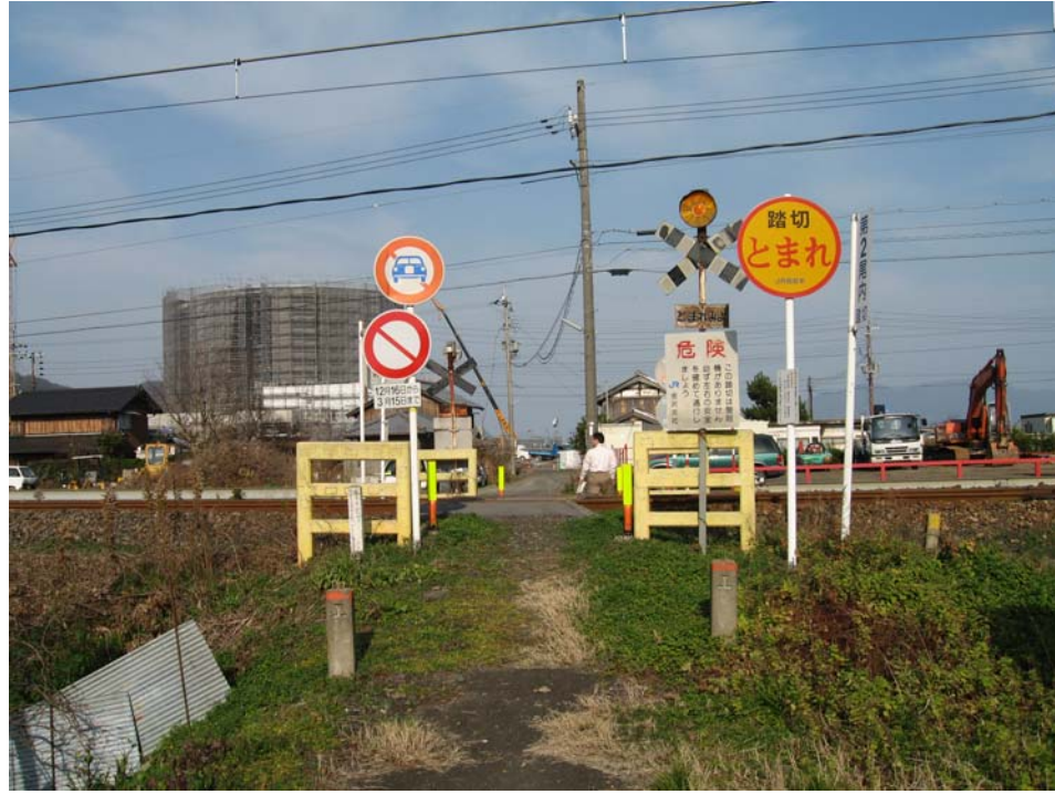
踏切注意看板、踏切注意柵
