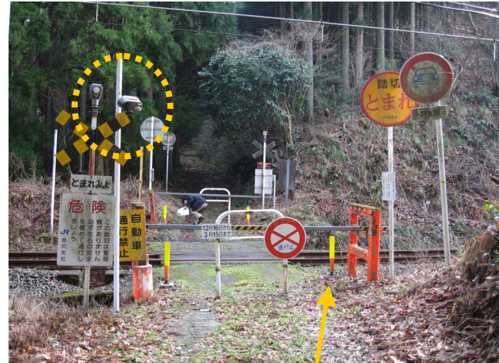
音声注意喚起装置、幅員制限ポール
