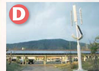
太陽光と風力で電力を得るLED照明 （高浜町・道の駅「シーサイド高浜」）
