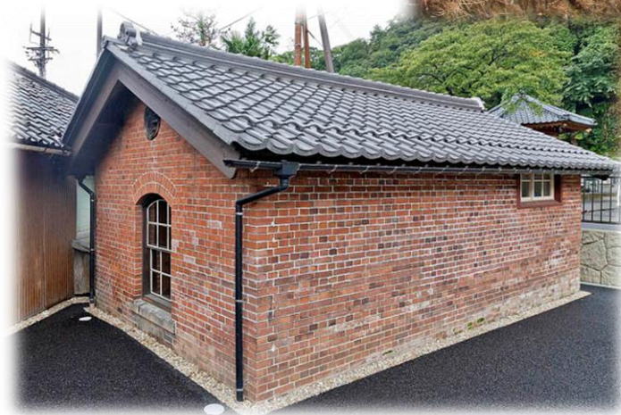
旧敦賀港駅ランプ小屋 (金ヶ崎停車場ランプ小屋)
