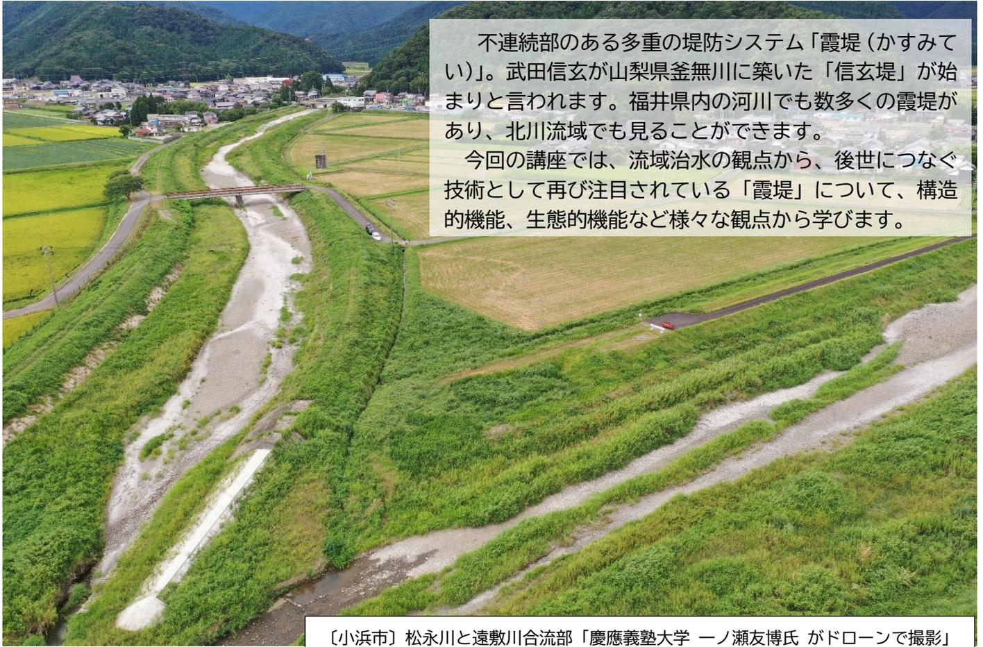
不連続部のある多重の堤防システム「霞堤(かすみてい)」。武田信玄が山梨県釜無川に築いた「信玄堤」が始まりと言われます。福井県内の河川でも数多くの霞堤があり、北川流域でも見ることができます。
