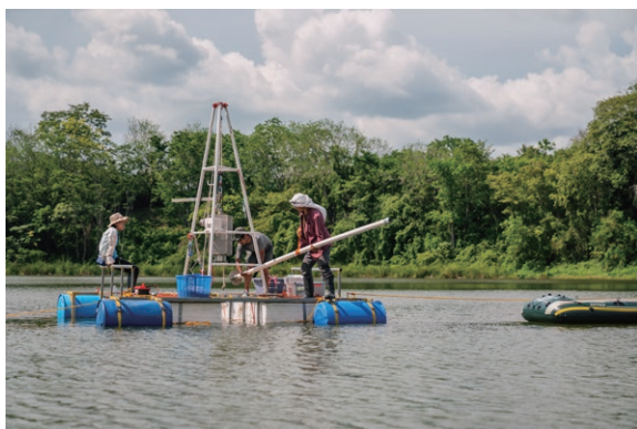
湖上での掘削作業
