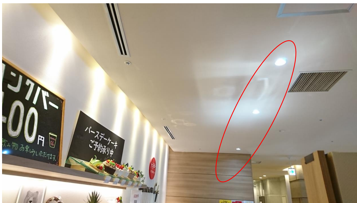
カフェの照明をLED化（丸い枠内）
