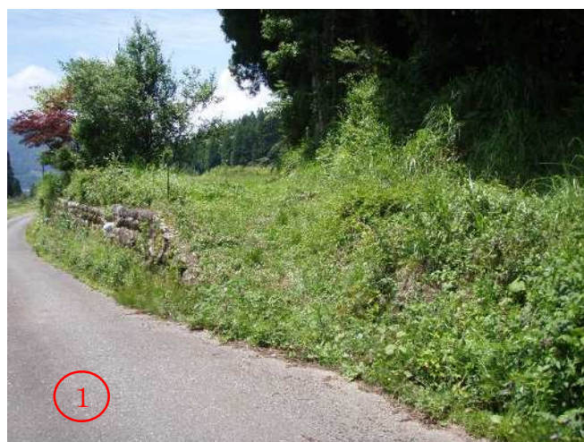
町道沿いの石積工終点 (学校林への入り口)
