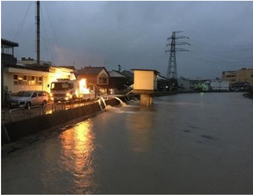
荒川へ排水作業中
