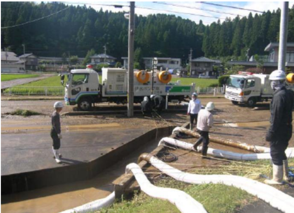
破堤箇所からの排水中
