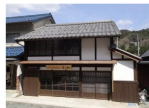
空き家の活用
