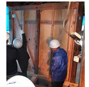
耐震改修工事の現場見学会
