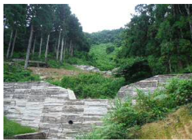
勝山市野向町深谷 (治山ダム工)
