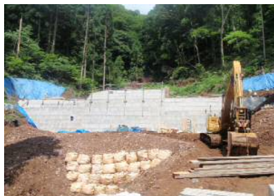
福井市薬師町 (治山ダム工)
