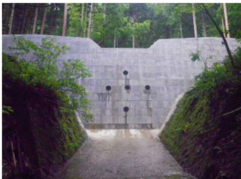
H25完成（既設治山ダム工の嵩上げ）
