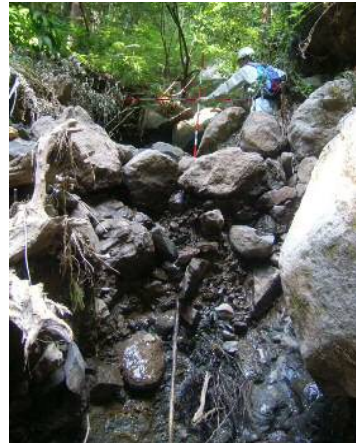
溪流荒廃状況
