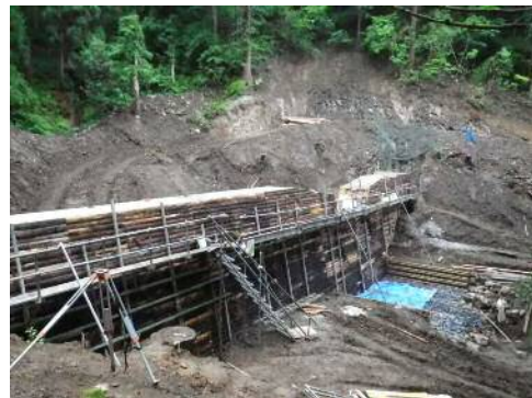
H26完成予定（治山ダム工）
