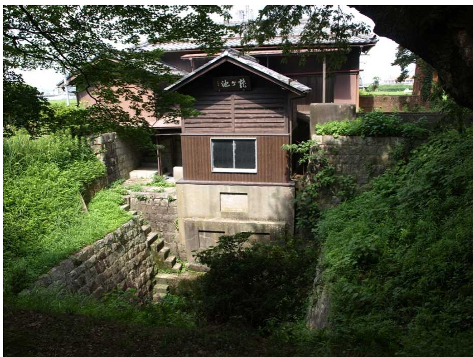
砂山池・龍ヶ池揚水機場
