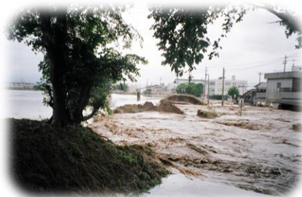
H16年7月福井豪雨による足羽川破堤 (福井市春日)
